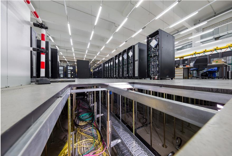
**Abbildung 2:** Blick in den Unterboden unter SuperMUC-NG (Foto: Lenovo)
