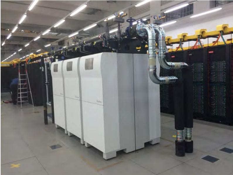
**anfallende Abwärme wird mittels Adsorptionstechnik in Kälte umgewandelt. Das LRZ nutzt diese energiesparende Variante der Kälteproduktion im Rechenzentrum zur Kühlung weiterer Systeme. Diesen innovativen Ansatz hat das LRZ in Zusammenarbeit mit der SorTech AG, einem Spezialisten für thermische Kühlung, und IBM Research – Zürich implementiert.**
